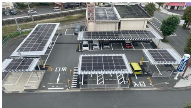
【本店駐車場設置 太陽光発電システム】
