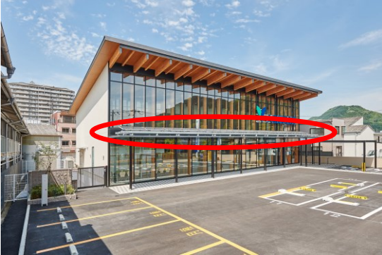
榛原支店の太陽光発電設備（一階ひさし部分）
